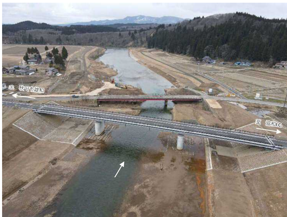
淀川 川原橋 完成 (大仙市・令和3年12月)
