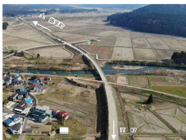
西目屋二ツ井線 荷上場工区 (藤里町～能代市・施工中)
