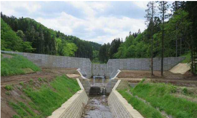
《高松岳の影響地域にある寺田川で、砂防えん堤や溪流保全工の整備》
