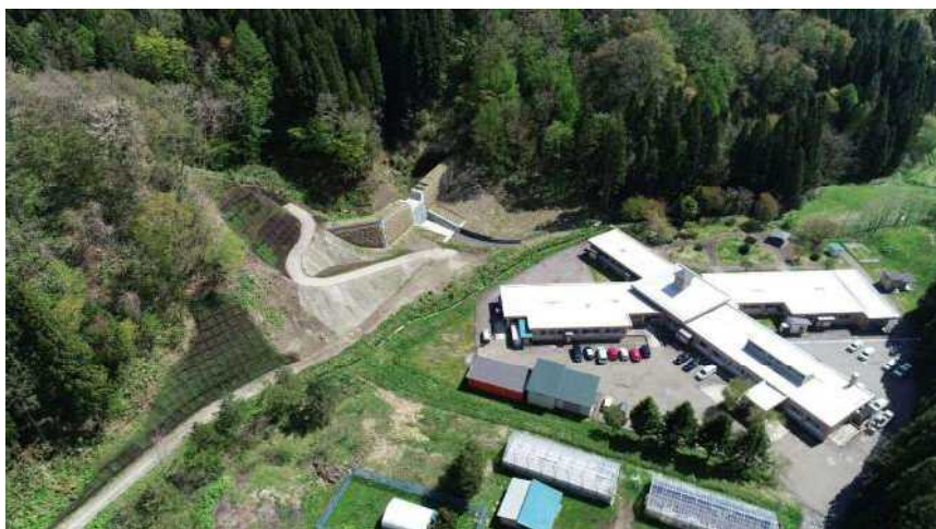
《要配慮者施設を保全するため、砂防えん堤を施工した小坂町・八九郎東沢》
