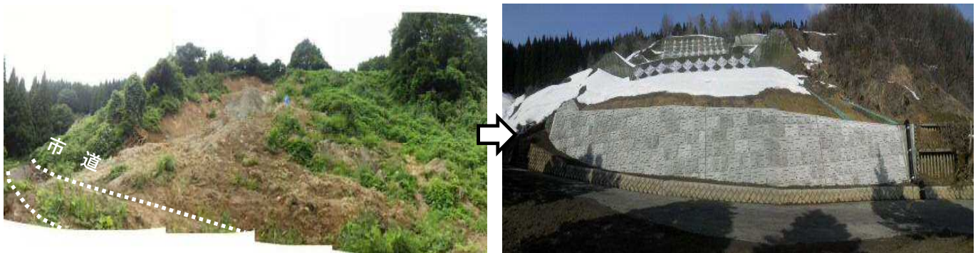
被災時(地すべりにより市道が埋塞) 復旧工事完了
