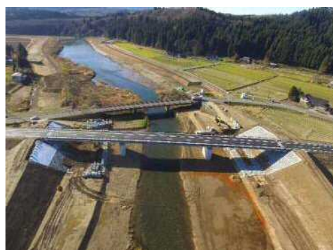
淀川(大仙市) 《橋梁架替工事(川原橋)》
