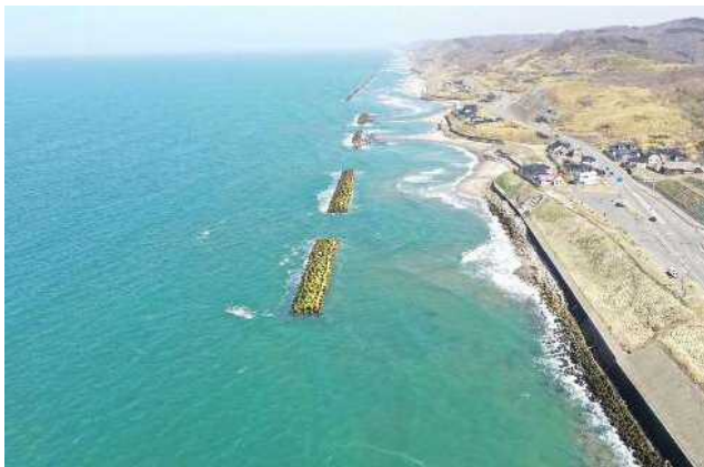
《離岸堤設置により侵食被害から県土を守る》 (本荘海岸(深沢地区) 由利本荘市)
