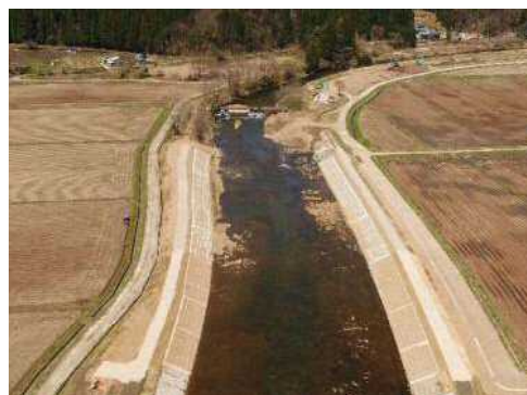
下内川(大館市) 《築堤・護岸工事》
