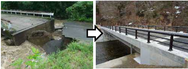
被災 復旧工事完了
