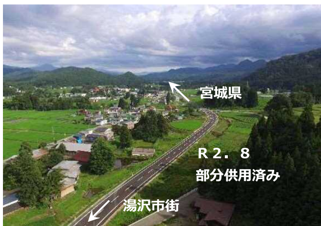
国道398号 湯沢市 稲庭バイパス
