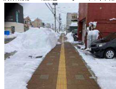
無散水融雪歩道 (主)大館停車場線 大館市
