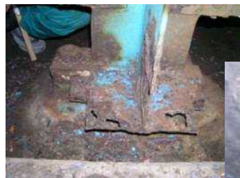
▲主桁及び支承部の腐食状況
