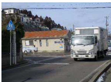
▲現況（歩道未設置）
