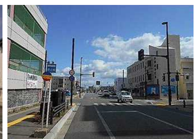
▲整備済み隣接工区
