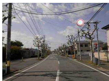
▲川尻総社通り線（現況）
