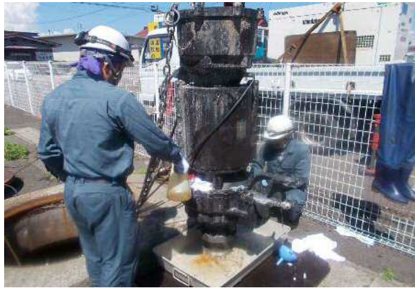
処理施設の点検
