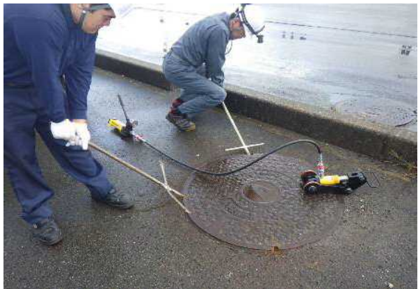
マンホールの点検
