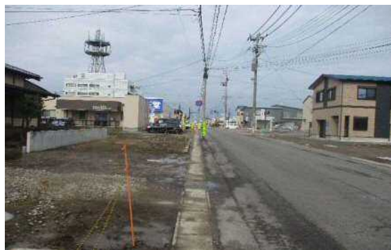
【進捗状況】 停車場栄町線(由利本荘市)
