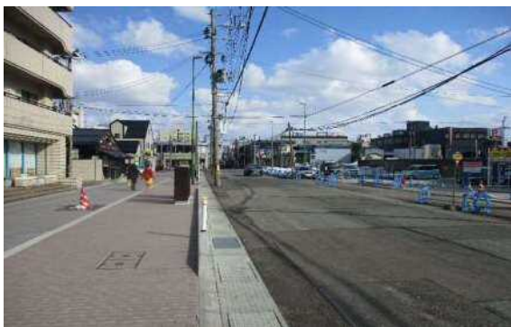
【進捗状況】 川尻広面線(秋田市)
