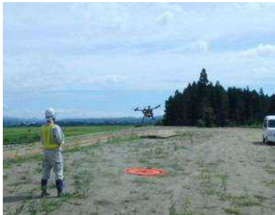
UAVによる起工測量状況
