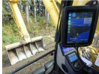
ICT建設機械による施工状況
