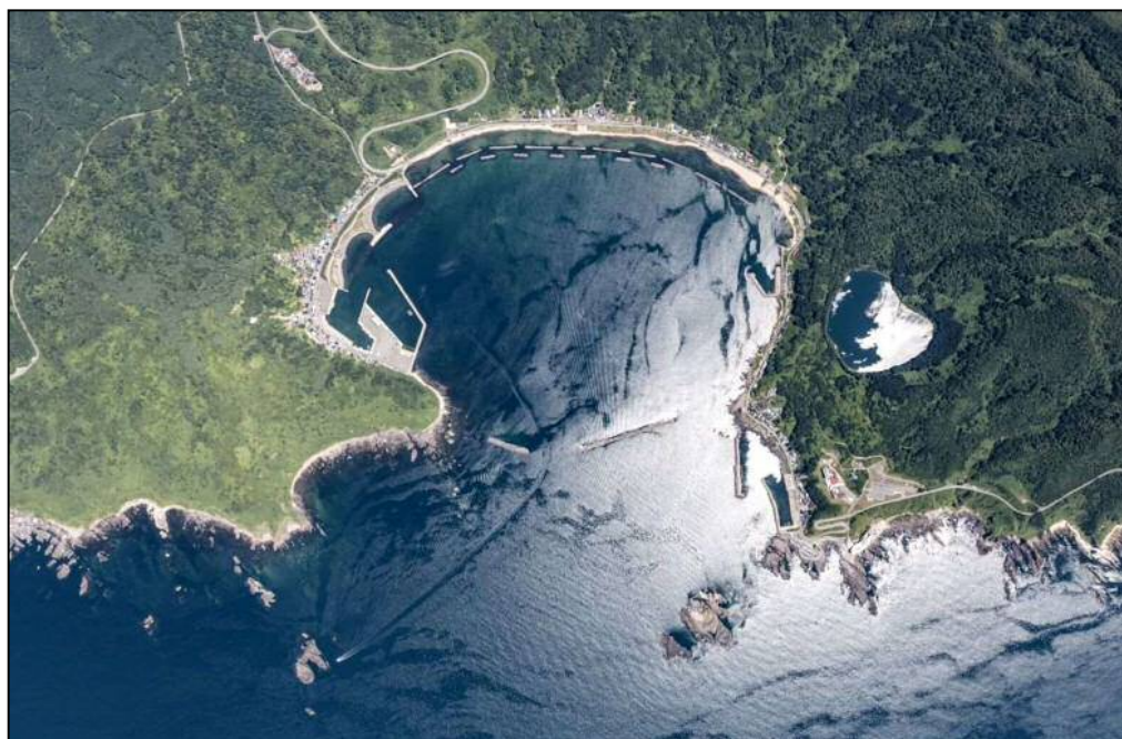
戸賀港全景(令和3年7月撮影)
