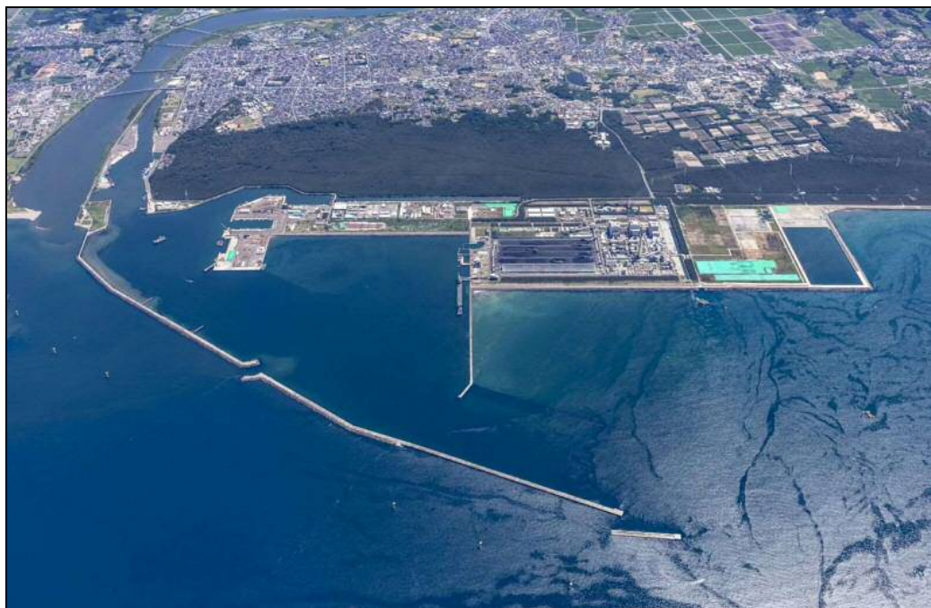
能代港全景(令和3年7月撮影)
