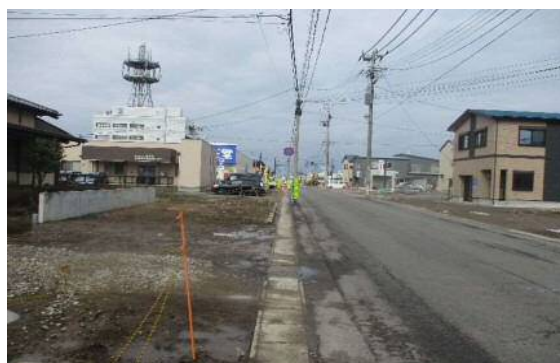
【進捗状況】 停車場栄町線(由利本荘市)
