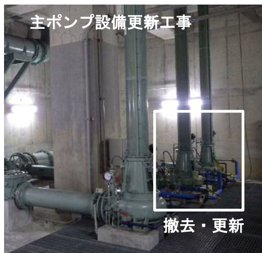
大曲中継ポンプ場（大仙市）
