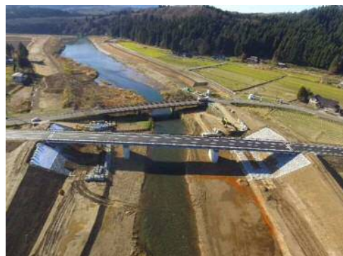
淀川(大仙市) 《橋梁架替工事(川原橋)》
