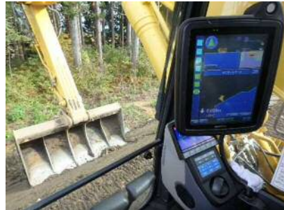
ICT建設機械による施工状況
