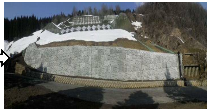
復旧工事完了
