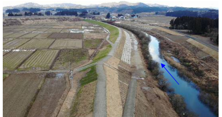
復旧工事完了
