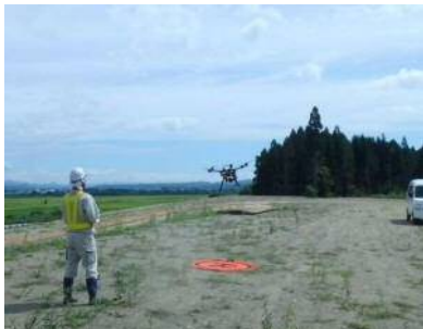
UAVによる起工測量状況
