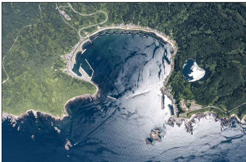
戸賀港全景(令和3年7月撮影)
