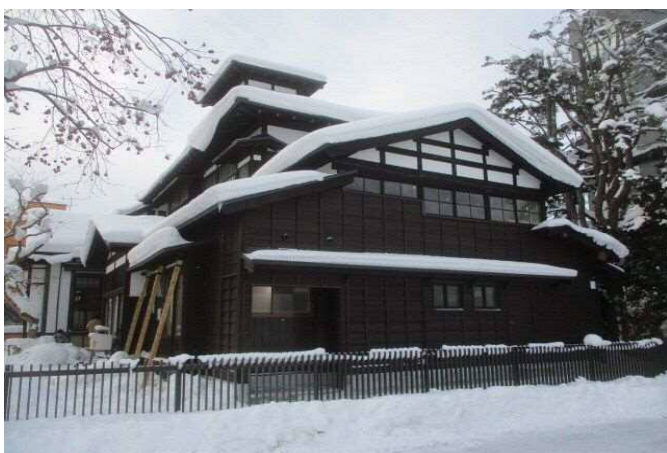
大館城下町地区 (歴史的風致形成建造物整備)
