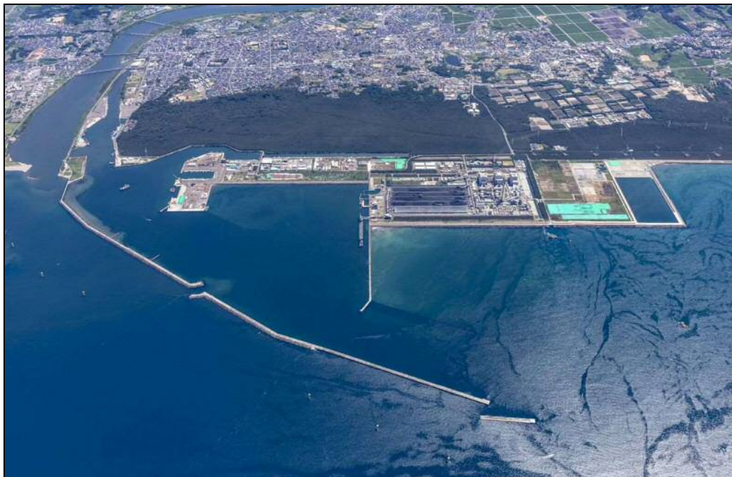
能代港全景(令和3年7月撮影)
