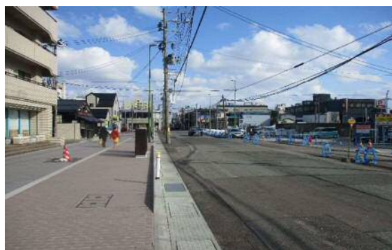
【進捗状況】 川尻広面線(秋田市)
