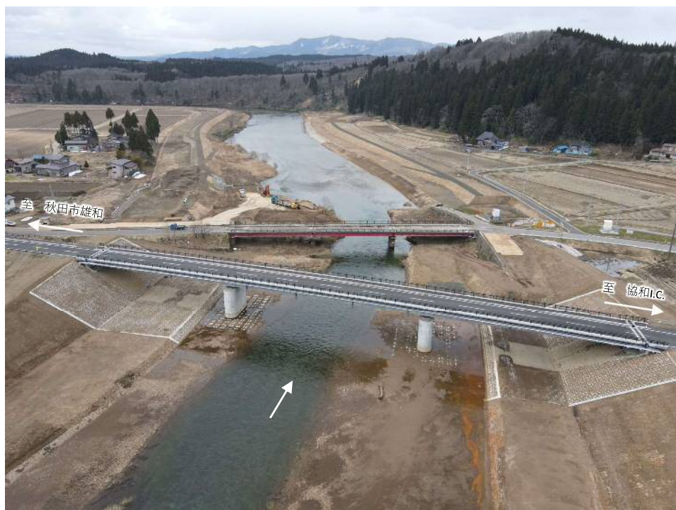
淀川 川原橋 完成 (大仙市・令和3年12月)
