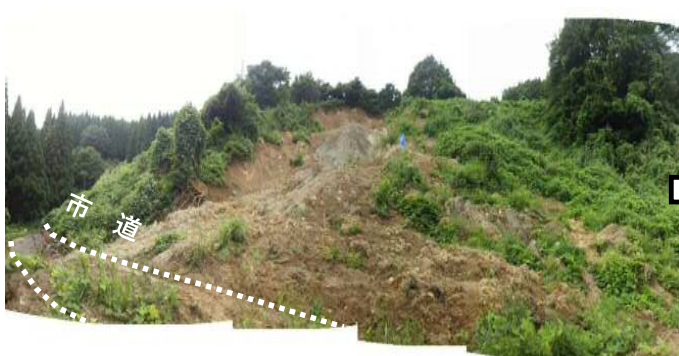
被災時(地すべりにより市道が埋塞)
