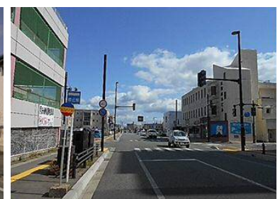
▲整備済み隣接工区
