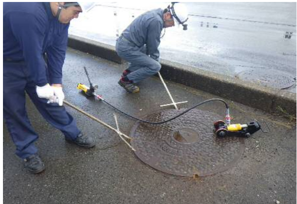
マンホールの点検
