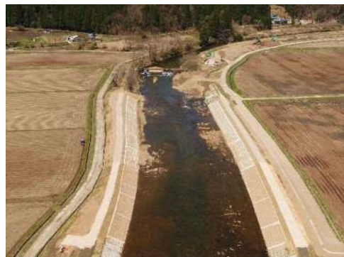
下内川(大館市) 《築堤・護岸工事》
