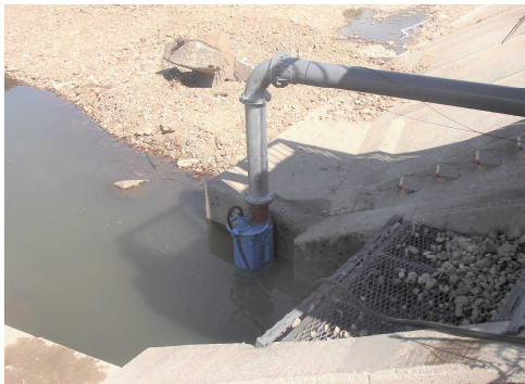
応急用ポンプ設置状況
