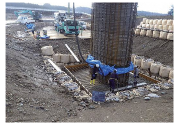
橋梁の耐震補強工事
