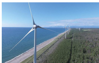
風の松原風力発電所（能代市）
