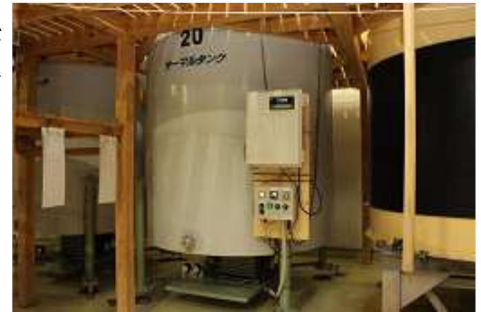
IoTセンサーを設置した発酵タンク
