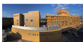
循環器・脳脊髄センター新棟での診療開始(平成31年3月)
