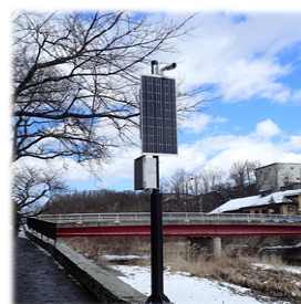
河川監視カメラの設置
