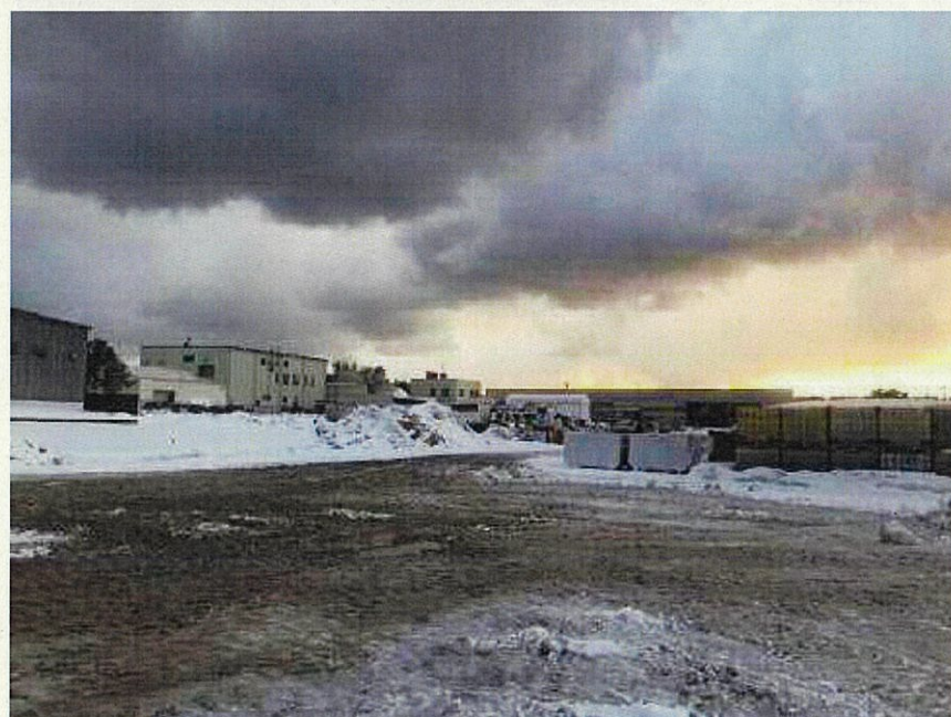
ユナイテッド計画㈱ 破碎・選別・保管施設 施設敷地 現況写真②
