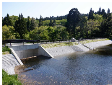
防災重点農業用ため池の改修
