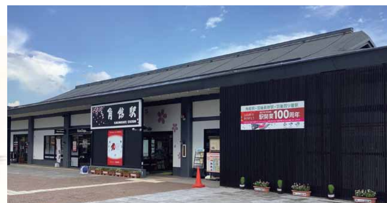
現在の駅舎(令和3年)
