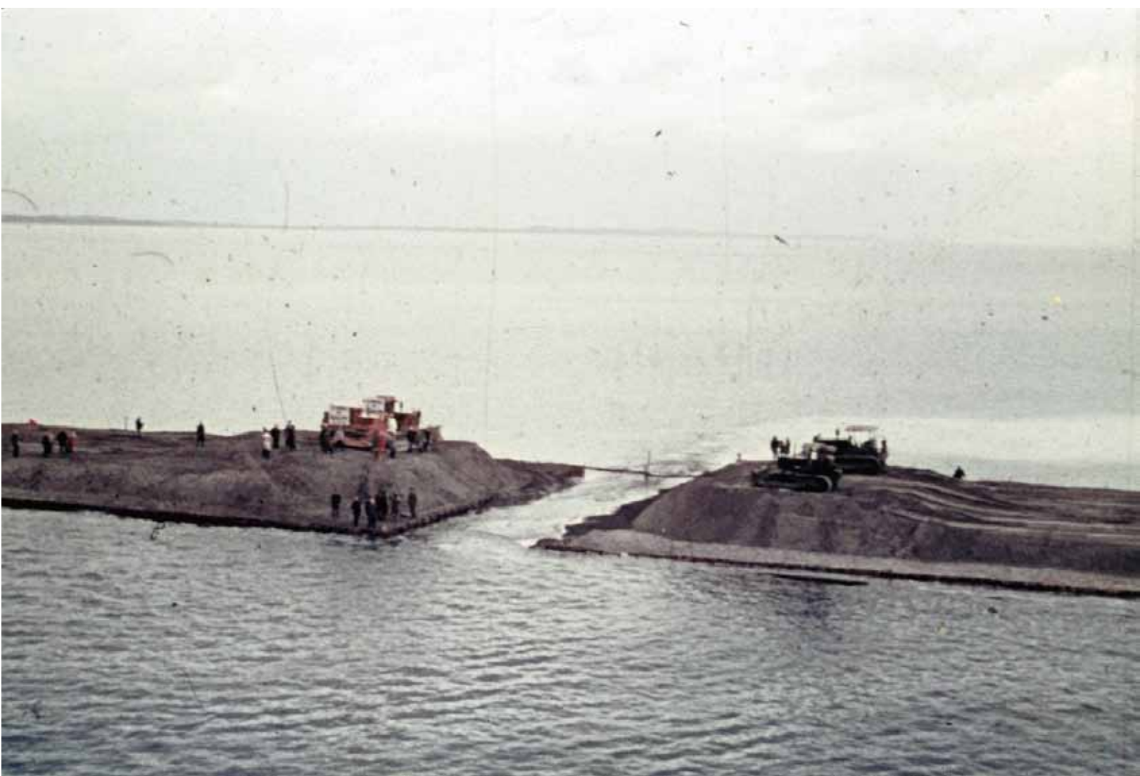
八郎潟干拓工事で、 全長52kmの堤防が閉じられる瞬間
