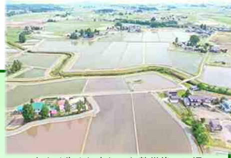
大きく生まれ変わった整備後のほ場
