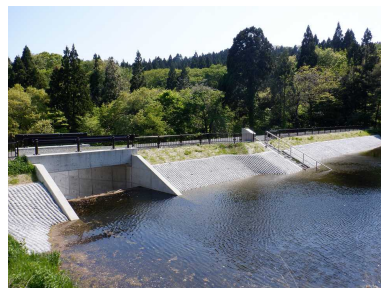
防災重点農業用ため池の改修
