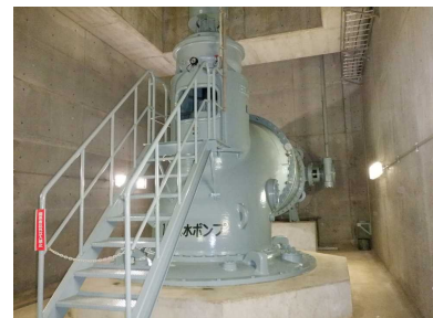
農業水利施設（排水ポンプ）更新
