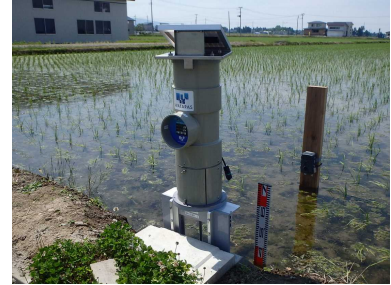
自動排水栓を活用した田んぼダム
