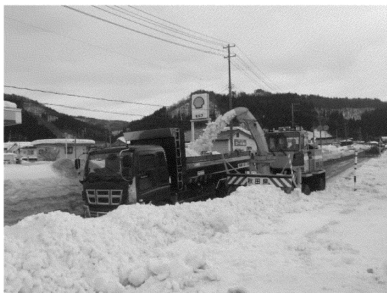
国道107号(横手市山内)
