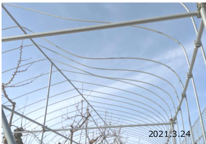
着雪の重みで歪んだアーチパイプ
