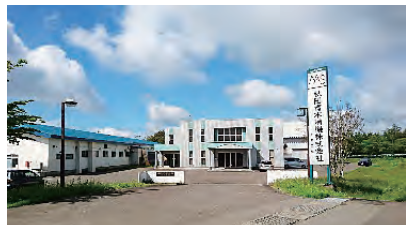
本社工場・事務所
