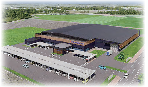
横手市第2工業団地内 2024年6月完成予定
