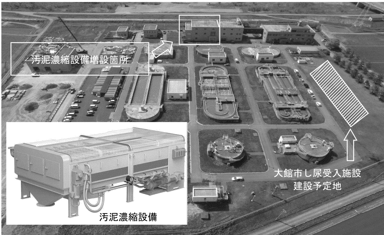
大館処理センター（大館市）
