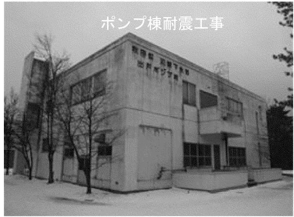
出戸中継ポンプ場（潟上市）
