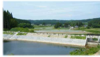
防災重点農業用ため池の改修
