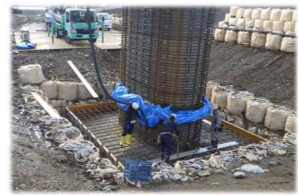
橋梁の耐震補強工事
