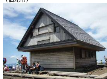
十和田八幡平国立公園 【国】阿弥陀池避難小屋・玉川温泉駐車場 田沢湖抱返り県立自然公園 【コ・県】春山公衆トイレ、モヤ森自転車道、 夏瀬橋等 (仙北市)
