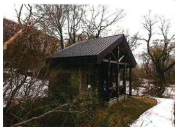
きみまち阪県立自然公園 【コ・県】頂上公衆トイレ・給水施設・ 遊歩道等 (能代市)
