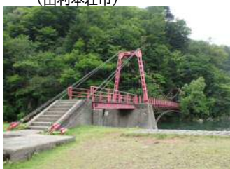
鳥海国定公園 【国・県】法体の滝園地吊り橋・歩道・ 炊事場 (由利本荘市)
