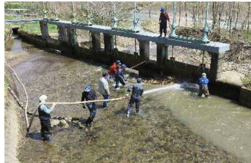
～消防団と連携し水門土砂撤去～
