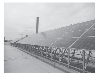
県庁舎屋上に設置した 太陽光発電設備
