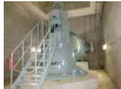
農業水利施設の排水ポンプの更新
