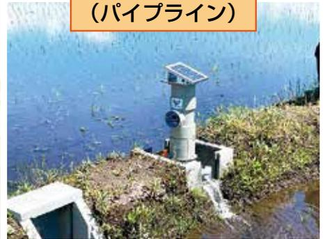
スマート農業を見据え用排水路を暗渠化しターン農道を整備するとともに、水稻エリアにICTによる遠隔操作が可能な自動給水栓を設置したほ場整備を実施。ターン農道の有効性や水管理労力の削減、用水節減効果等を検証するほか、スマート農業に対応した基盤整備モデル地区としてPRしていきます。
