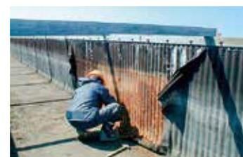
腐食が進む幹線用水路
