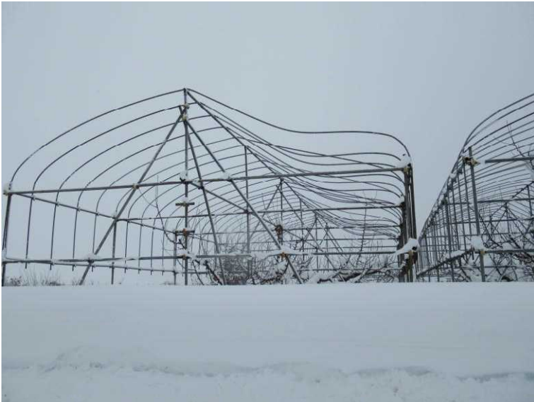
写真 4 おうとう用雨よけハウスの 損壊（湯沢市）
