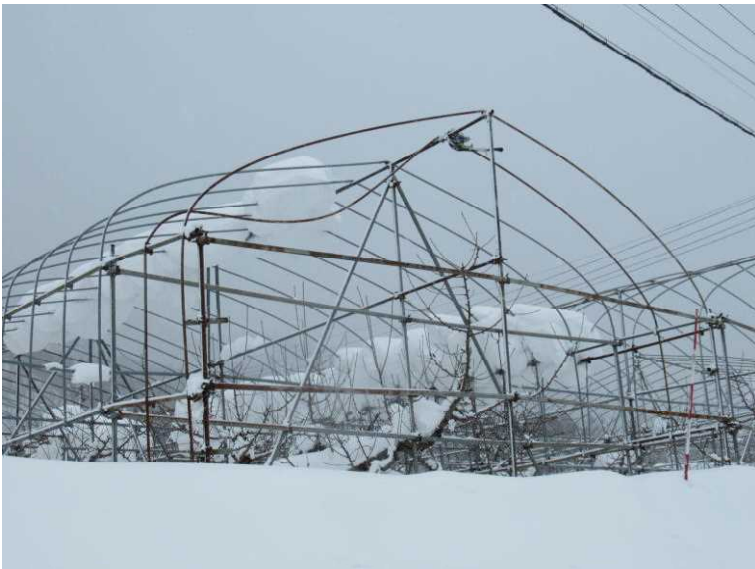
写真 5 パイプへの着雪により、おう とう用雨よけハウスが損壊し ている様子（湯沢市）
