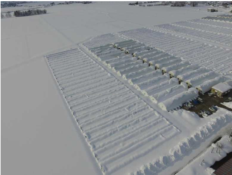
写真 1 ほうれんそう団地のパイプ ハウスの倒壊（横手市）
