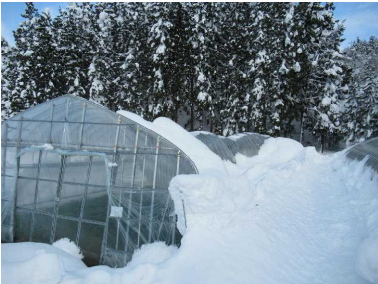
写真 2 セリ用パイプハウスの倒壊 （湯沢市）
