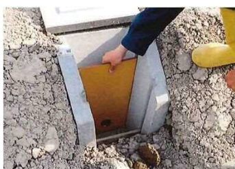
(流量調整板の設置状況)
