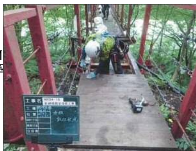
床板設置状況
