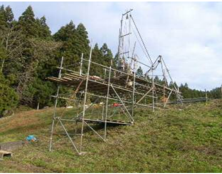
ボーリング作業状況
