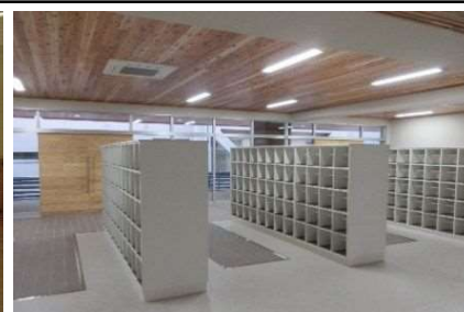
完成(生徒昇降口)
