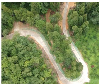
ドローンによる施工管理
