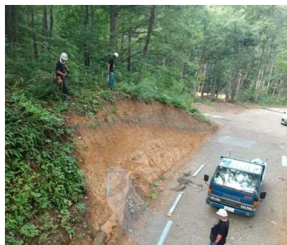
ドローンによる安全監視
