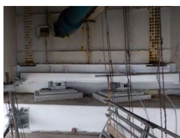
水平力分担構造
