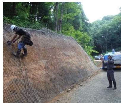
サイレン付き拡声器による施工指示
