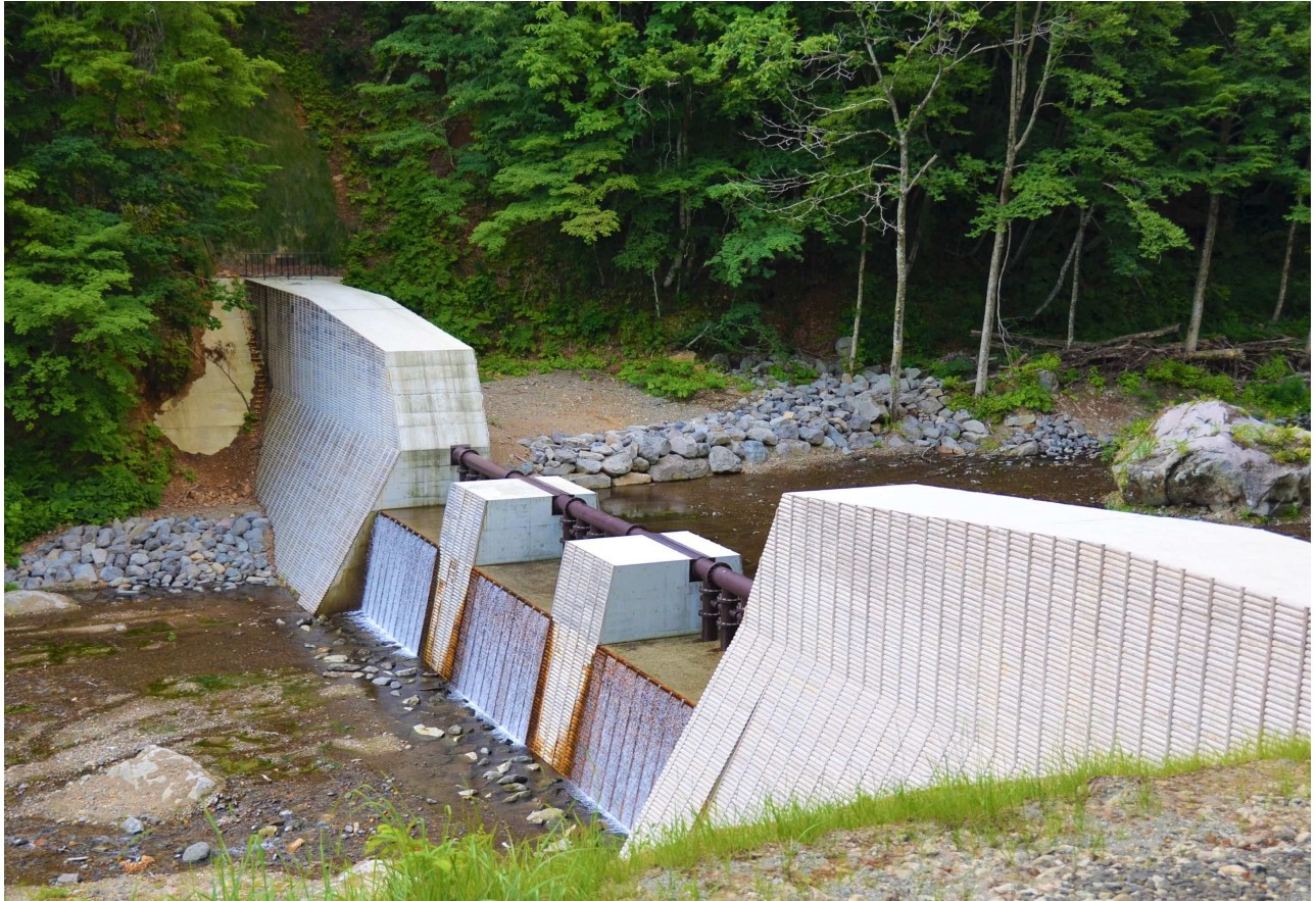
第40回秋田県優良工事表彰から 岩井沢地区 治山施設機能強化工事 RF1115A011
