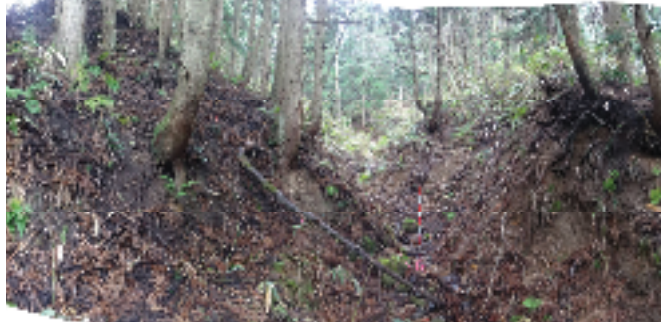
No.3 谷止工〔着手前〕
