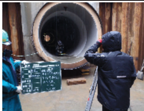
出来形検測状況
