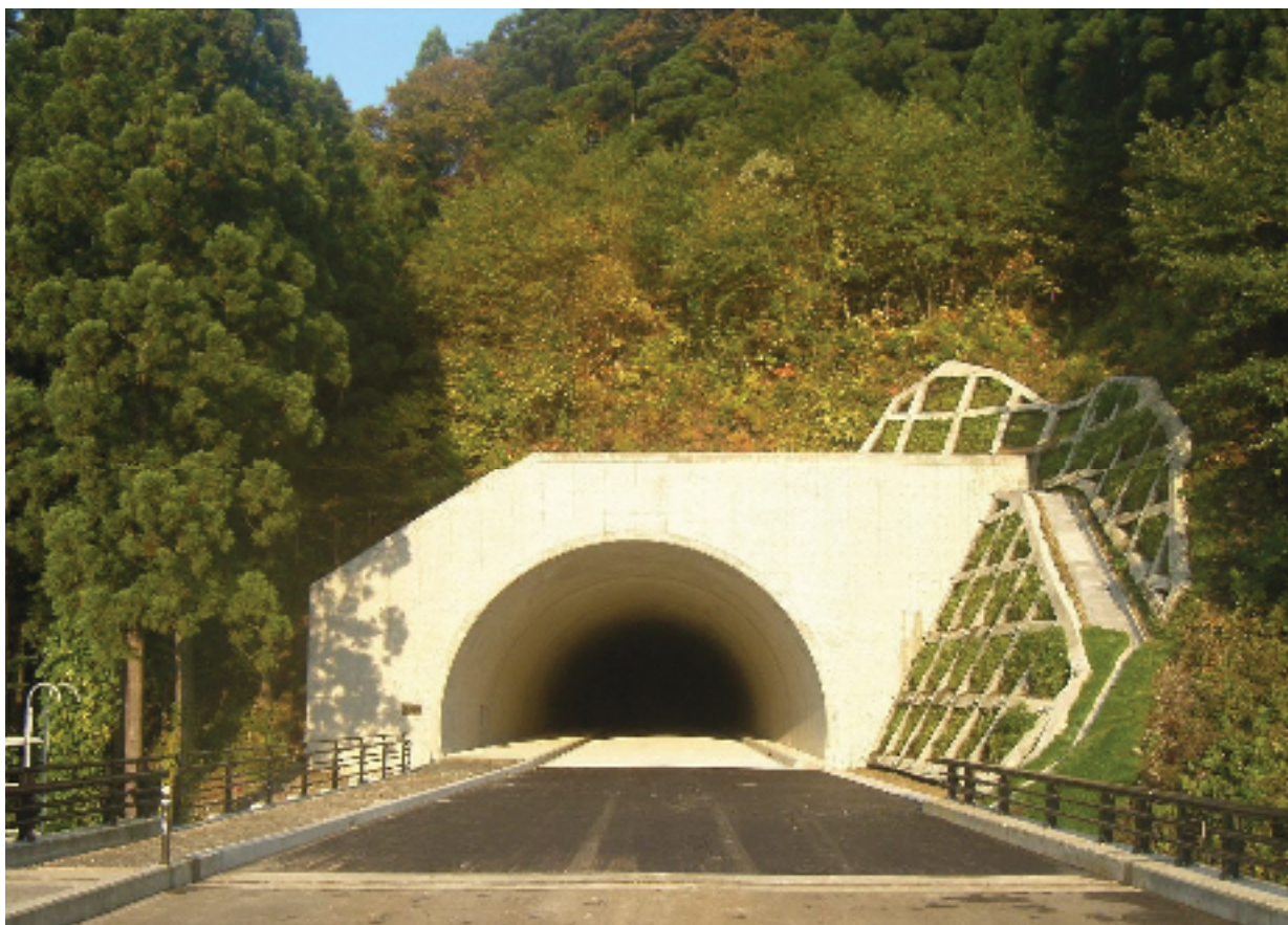
第39回秋田県優良工事表彰から 地方道路交付金工事（改築） 27-HF54-N1 国道285号 滝ノ沢バイパス（米内沢トンネル）
