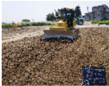
ICT機械による施工状況
