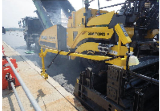
アスファルト舗設状況
