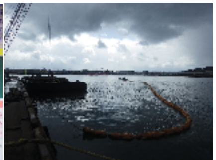
汚濁防止膜設置状況
