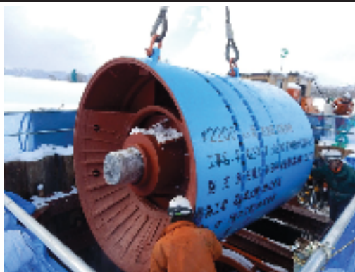
掘進機搬入状況
