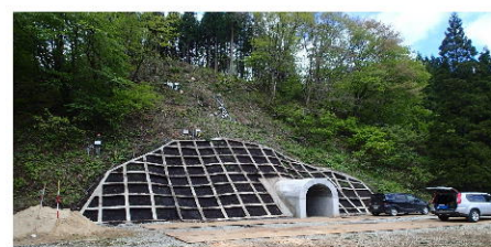
写.1 2号排水トンネルの施工状況(H29.5.17)
