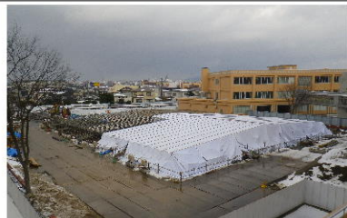
コンクリートの冬期養生
