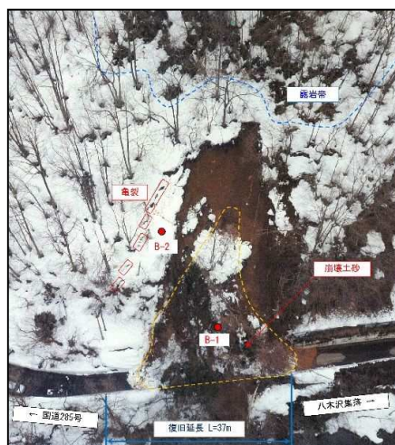
【災害発生時の状況】
