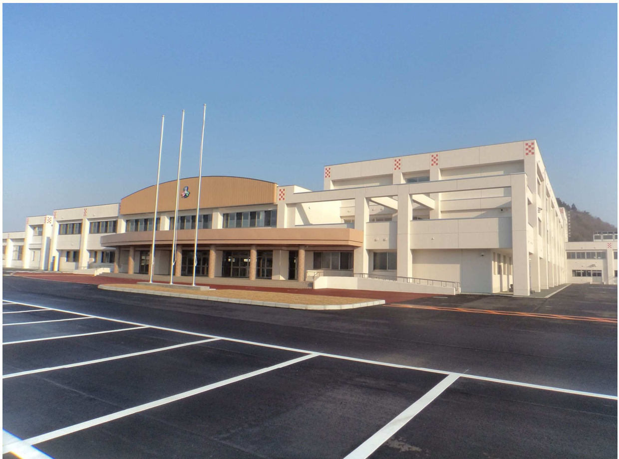
第37回秋田県優良工事表彰から 大館地区統合高校（仮称）校舎棟（A工区）建築工事
