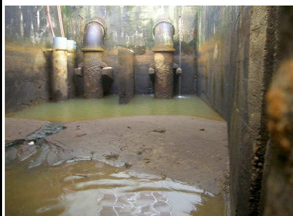
吸込み部（現況）
