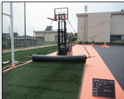
衝撃吸収材・人工芝敷設状況
