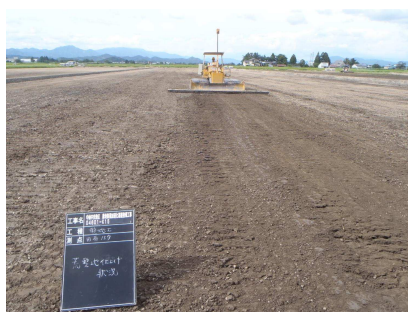
シートパイルによる整地
