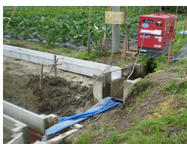
発電機設置状況
