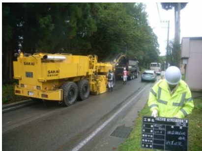
路面切削機による舗装版剥ぎ取り作業
