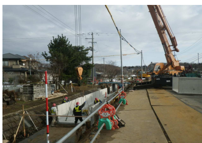
大型フリューム据付状況
