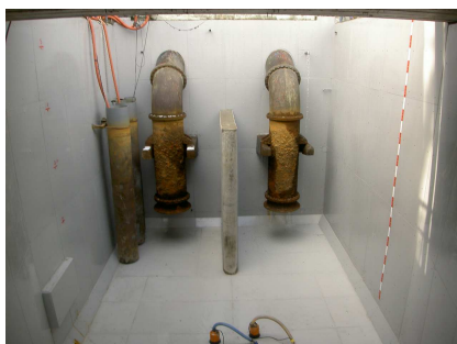
吸込み部（完成）
