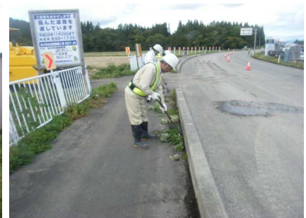
現場周辺のクリーンナップ、歩道除草作業
