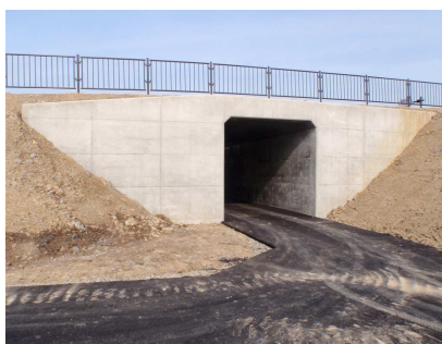
完成写真（函渠）
