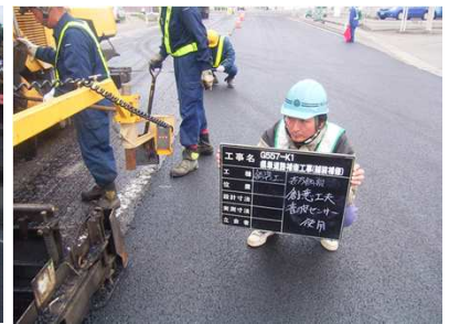
スクリッド自動制御装置を使用することで均一な品質確保
