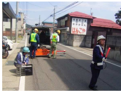
レーザー・プロファイラーによる起工測量
