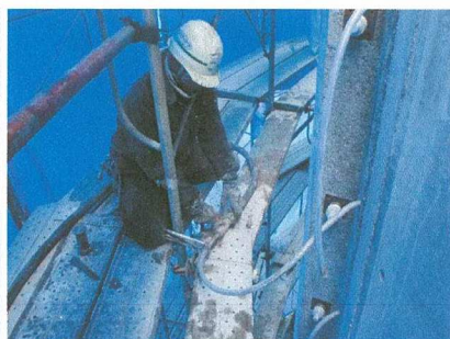
グラウト注入
