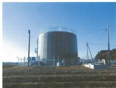
高架水槽全景
