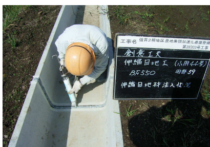
伸縮目地施工状況
