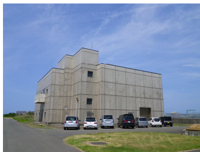
全景(ブロワ棟)
