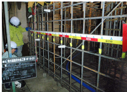
「鉄筋測定定規」による出来形管理
