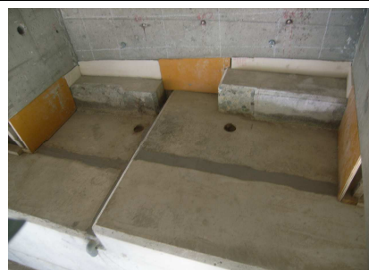
新旧打継部に止水シールを施工
