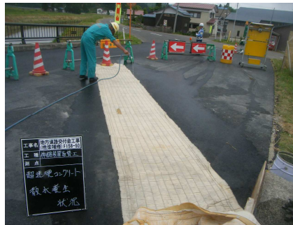
ジェットコンクリート打設後の散水養生
