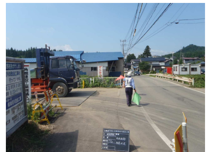
工事車両出入口
