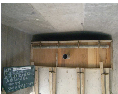
横桁増厚部の締固不足を防止するため2リフトで打設
