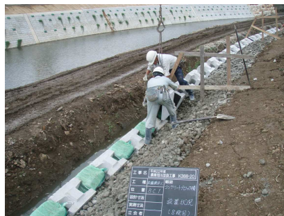
ブロック施工状況
