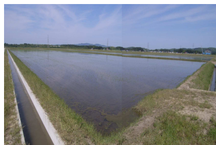
完成写真(全景)
