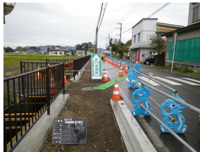
保安施設設置状況
