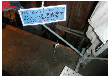
「おんどとり jr.」による養生温度管理
