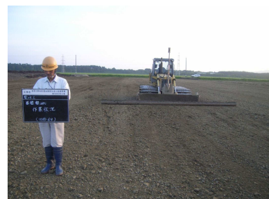
鉄柱による仕上げ状況
