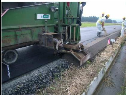
サイドフィードローダによる路肩盛土の施工状況
