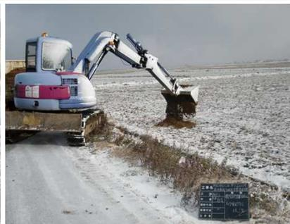
小型機械による施工 (BH0.2m<sup>3</sup>)
