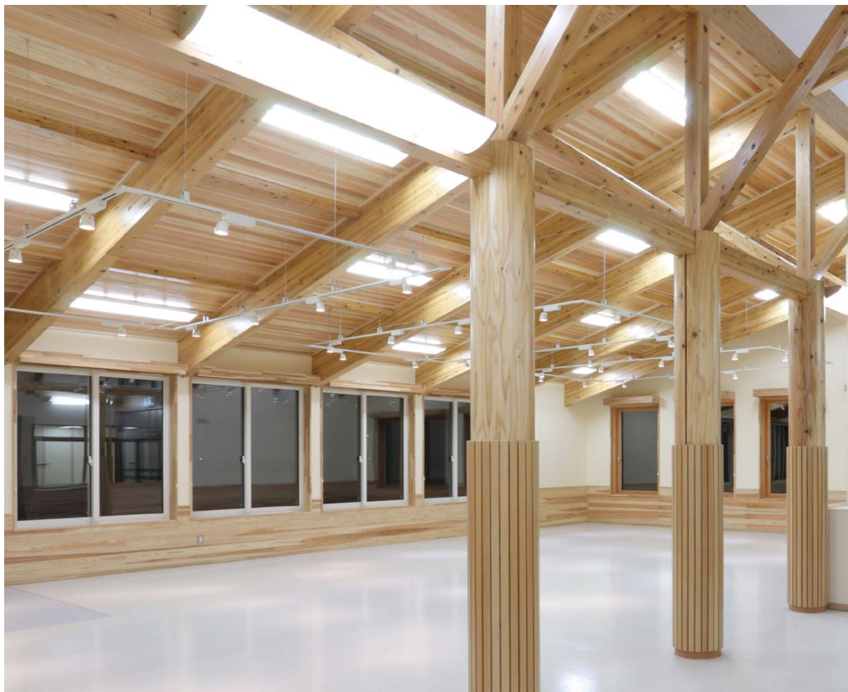
第31回秋田県優良工事表彰から こども総合支援エリア（仮称）建築工事（D工区） （秋田市上北手）
