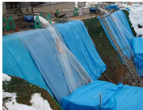
溪流保全工施工時の掘削面が崩落して、民家へ支障を及ぼさないように、ブルーシートや落石防止ネットを自主的に施工して創意工夫に努めた
