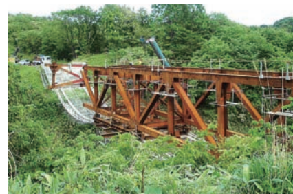
防護ネットを作業箇所ごとに設置
