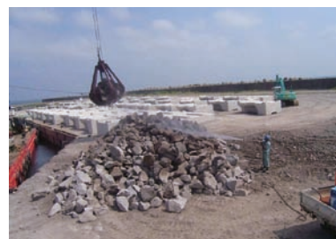
基礎工に使用する捨石の洗浄作業
