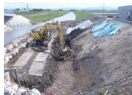
河床部の軟弱地盤処理
