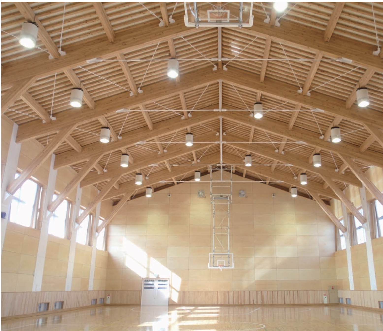
第30回 秋田県優良工事表彰から 秋田県立矢島高等学校校舎等改築電気設備 (由利本荘市矢島町)
