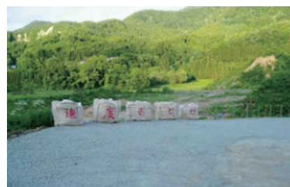
運搬路の安全対策
