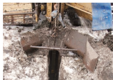
掘削断面崩落防止
