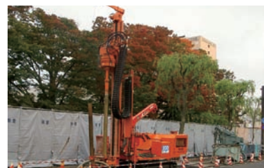
防音シートの設置・施工機械の省スペース化
