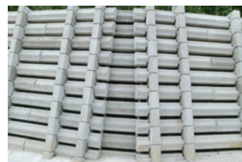
カーブ連続箇所の処理
