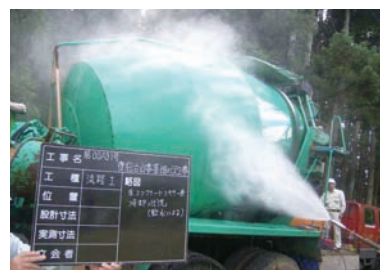
コンクリート温度の上昇を防ぐ工夫
