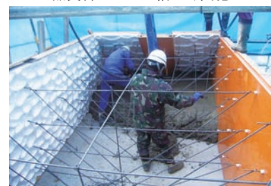
化粧型枠表面凹凸部に気泡が入らないよう慎重に締め固め
