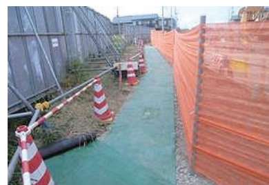
仮設歩道の整備
