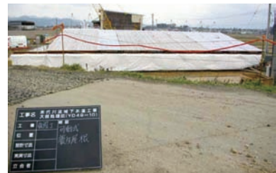
コンクリート養生のためのローラー付き移動式屋根
