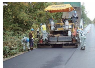
アスファルト施工状況
