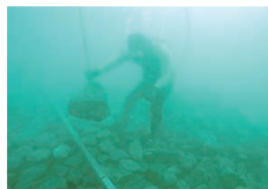
水面下でのブロック据付状況
