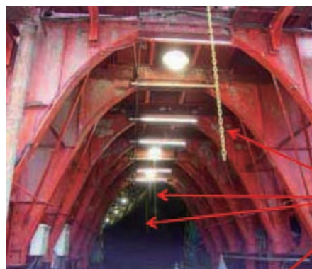
ダンプ誘導用のプラチェーンを設置
