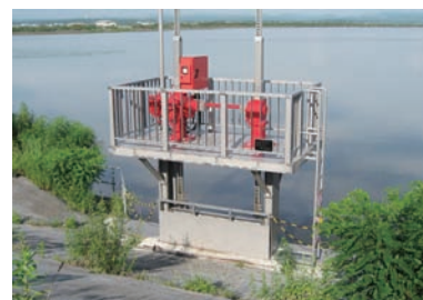
ゲート完成写真
