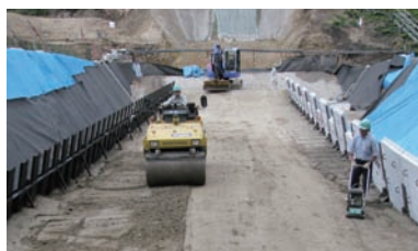
入念な締め固めにより安定した品質を確保
