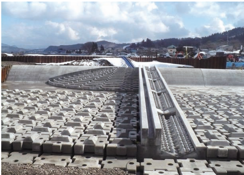
頭首工全景（下流より）
