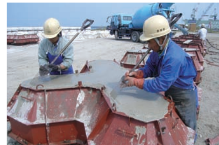
ブロック表面の気泡痕除去の工夫
