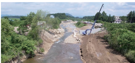
仮締切り施工状況
