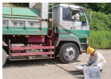
トラックスケールによる過積載防止対策
