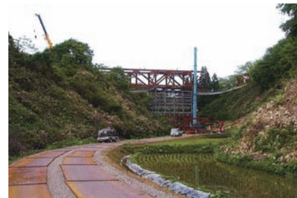
農作業車等と競合する工事用道路
