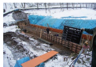
冬期間に関わらずコンクリートの品質管理をきめ細かく実施
