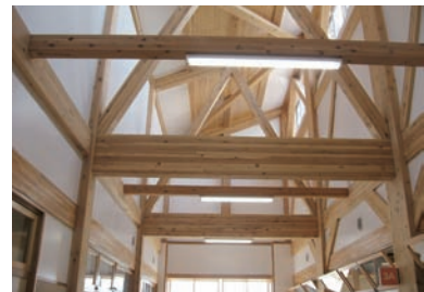
電気配線の設置を工夫
