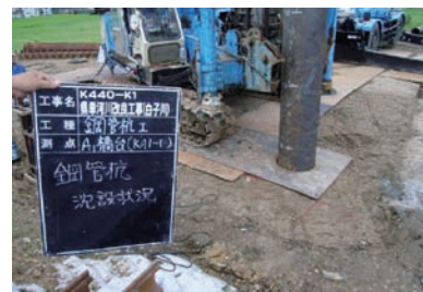
杭基礎打ち込み位置の管理
