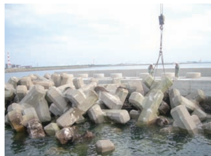
GPS管理によるブロック据付
