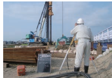
杭基礎打ち込み偏心量管理
