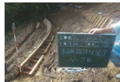
地山へのすり付けを考慮した木柵据付
