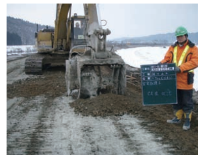
部分的な攪拌状況
