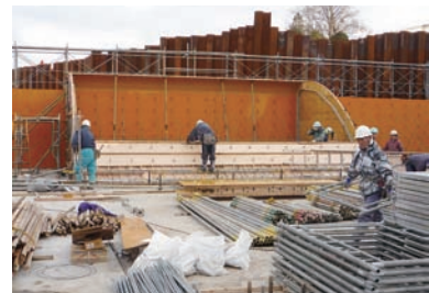
固定堰曲線部の型枠設置状況
