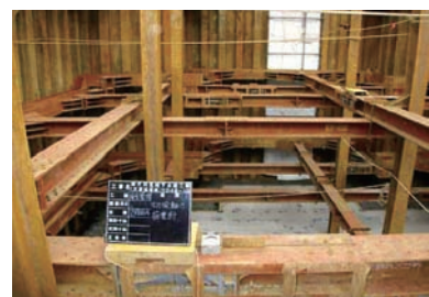
切梁荷重計を設置し工事の安全性を確保
