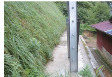
擁壁背面の浸食防止叩きコンクリート
