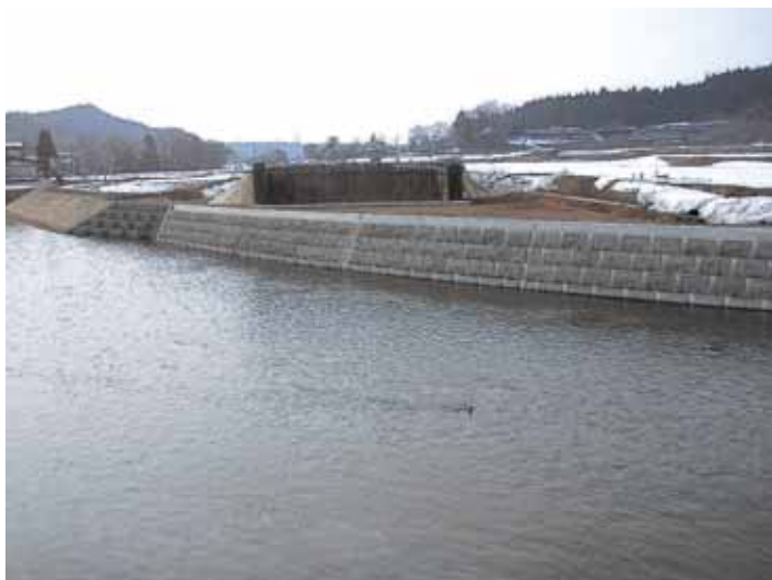
完成写真（A2橋台と護岸工）
