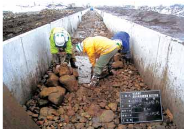
野面石の敷設状況
