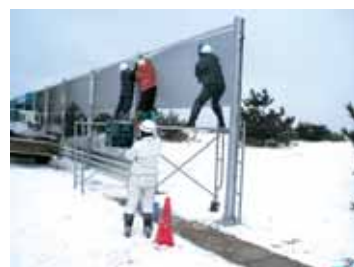
足場を設置した作業
