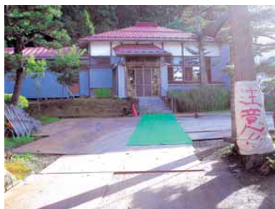
仮敷き鉄板の滑り止めマット
