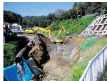
上部からの施工状況
