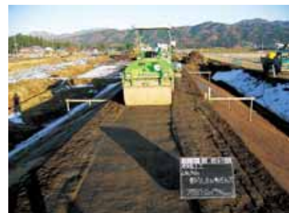
ローラーによる転圧状況
