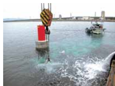
被覆ブロック据付状況
