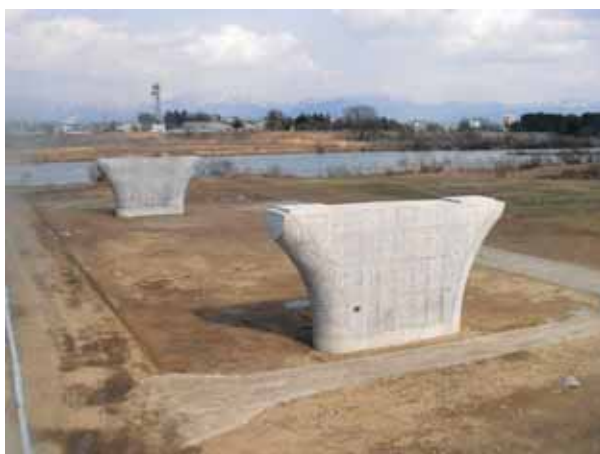
完成写真（橋脚P3, P4）
