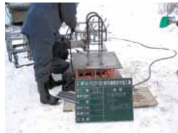
アンカー仮組立
