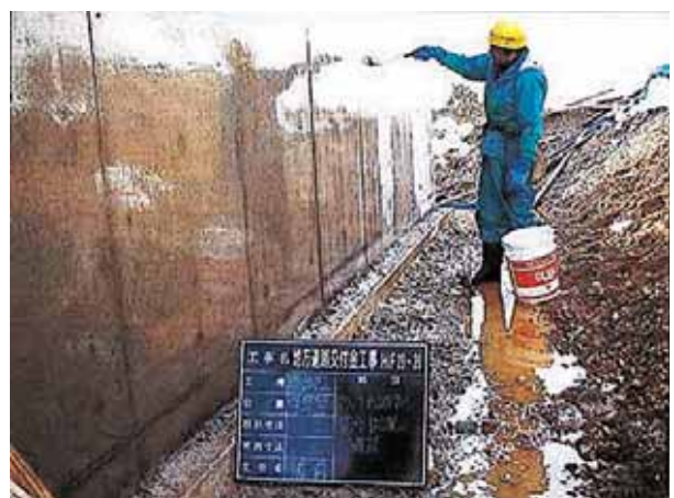
クラック低減剤施工状況
