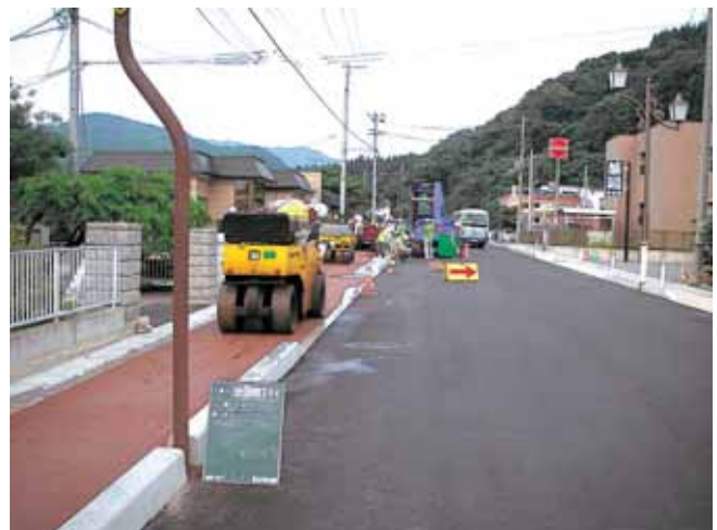
カラー舗装舗設状況
