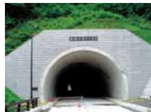
完成写真（終点側）
