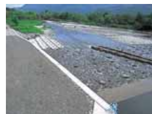
完成写真 (左岸上流から全景)
