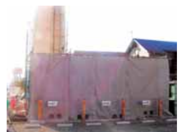
防音シート設置状況
