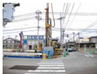
深層混合処理工法
