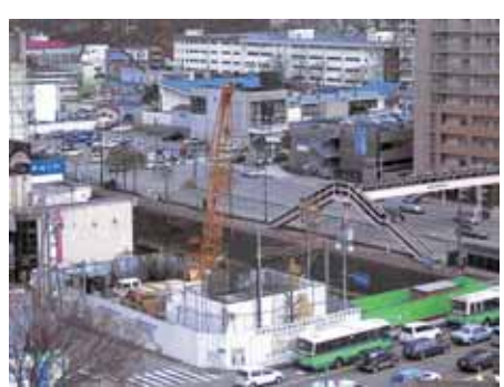
大町圧入状況
