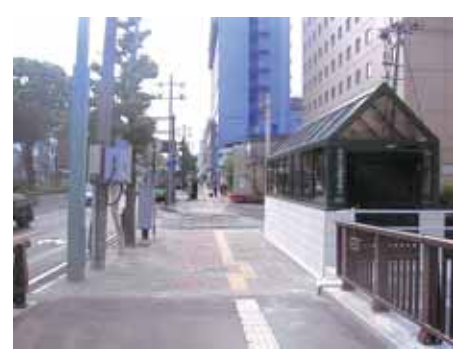
完成写真（大町避難口）
