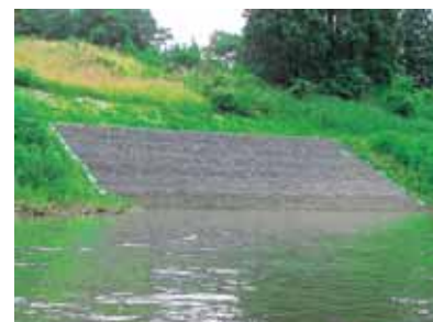
完成写真(全景) 大川端揚水機場：かごマット工
