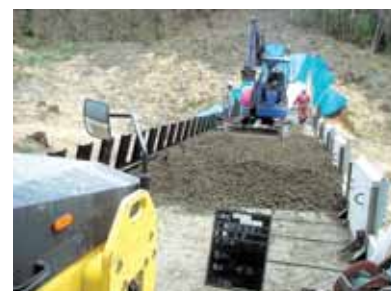
中詰材の敷均敷固め状況
