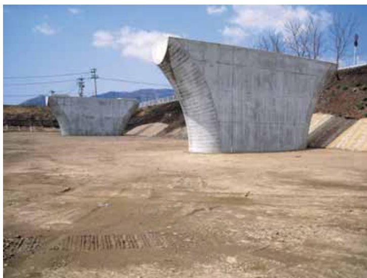
完成写真（橋脚P1, P2）
