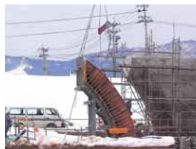
型枠・支保撤去状況
