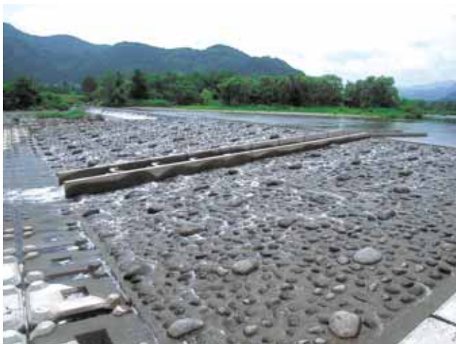
完成写真 (左岸下流から全景)
