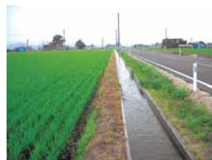
完成写真 (支線水路)
