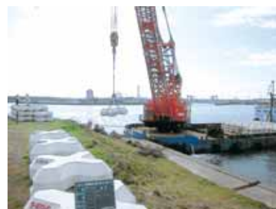
被覆ブロック積込状況
