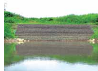
完成写真(全景) 杉の前揚水機場：ふとんかご工
