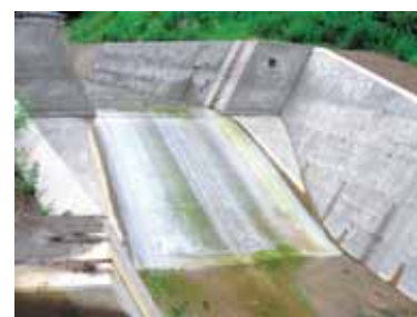
ラウンディング処理状況
