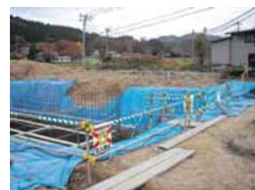
掘削面保護及び転落防止
