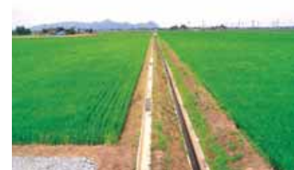
完成写真 (小排水路)
