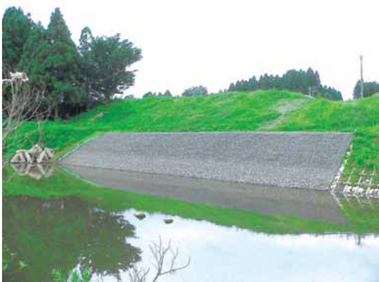
完成写真(全景) 福部羅揚水機場：かごマット工
