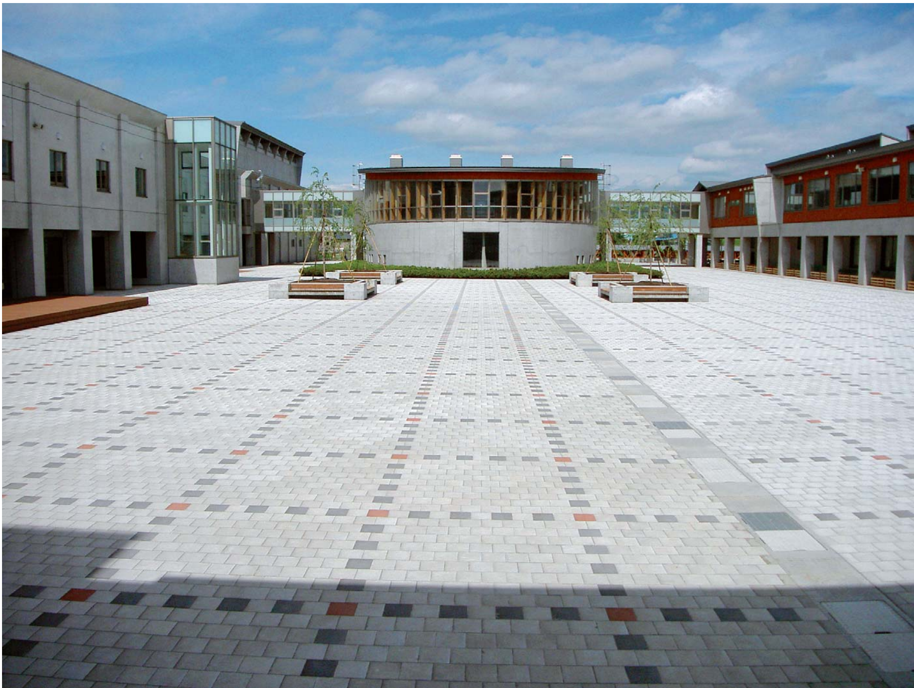
第28回 秋田県優良工事表彰から 秋田県立中高一貫教育校（県北地区）プール棟等建築工事 （大館市松木）
