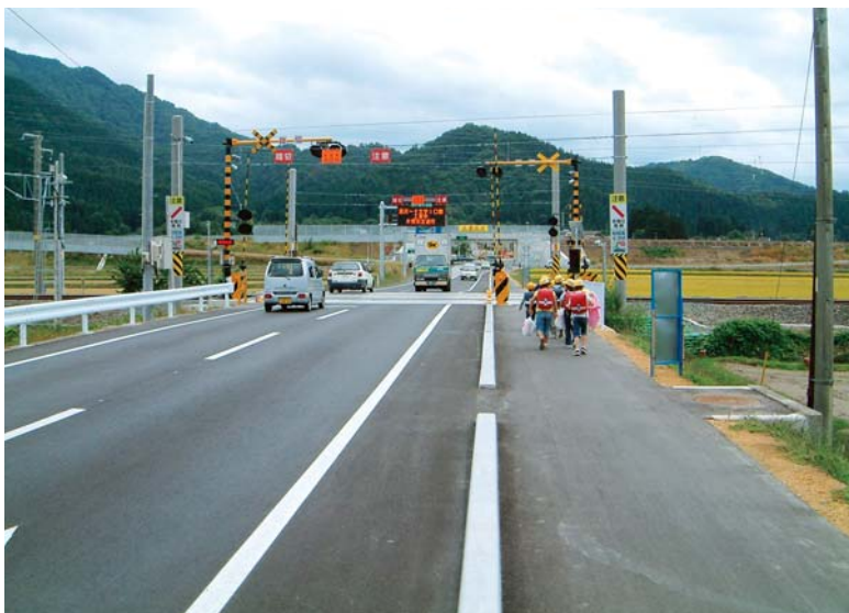
完成写真（全景）
