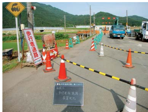
安全施設工（歩行者用通路）
