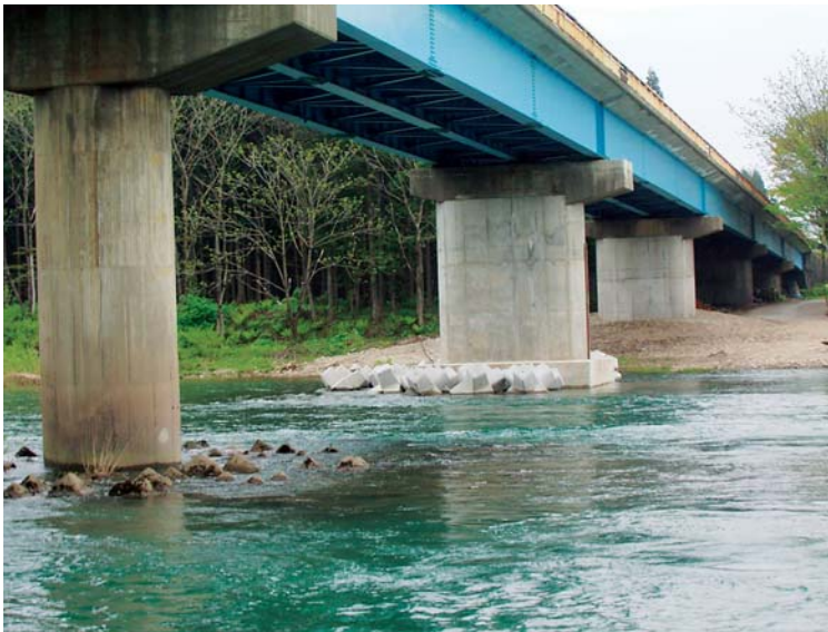
完成写真（橋脚 4基）
