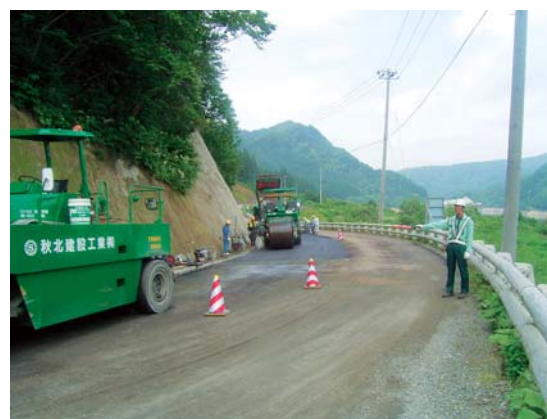
施工状況（交通誘導員を配置しながらの転圧状況）
