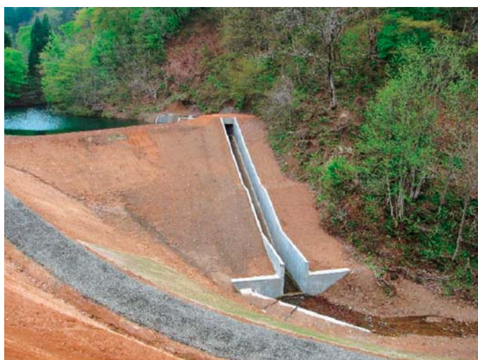
完成写真（洪水吐工）
