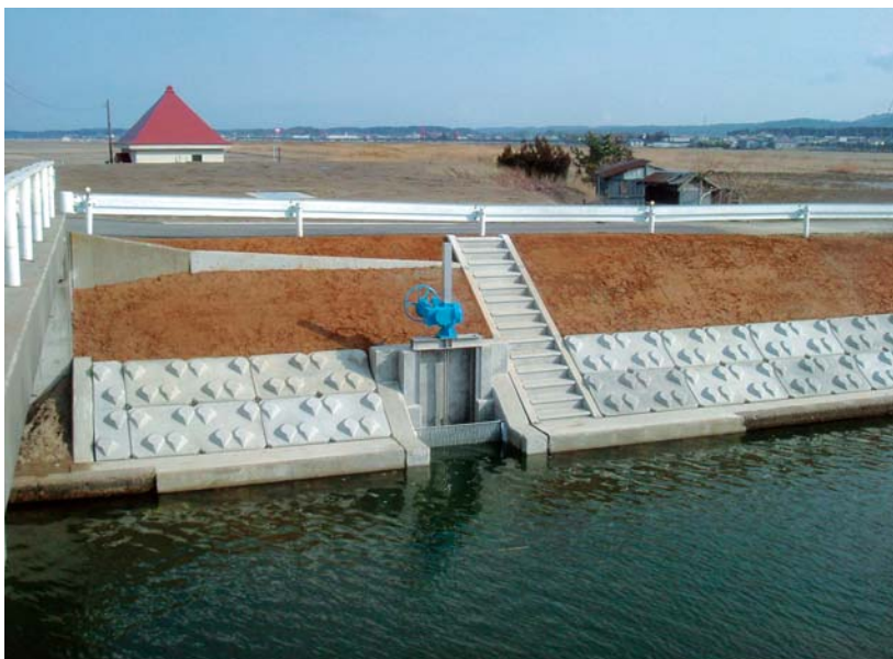
完成写真（全景）
