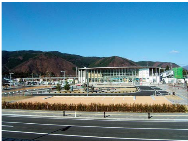
完成写真（全景）
