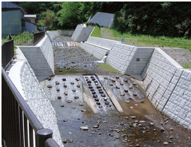
完成写真（全景）
