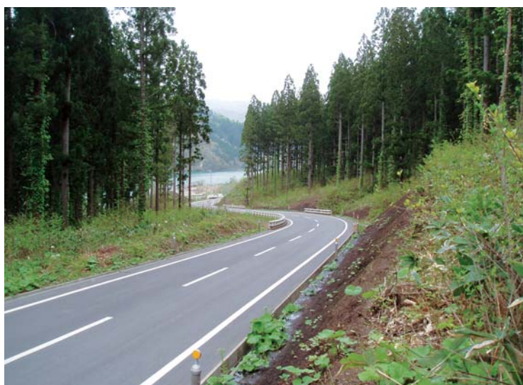
完成写真（見事な舗装面の仕上がり）
