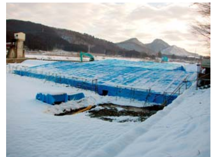
防雪対策（雪囲い）
