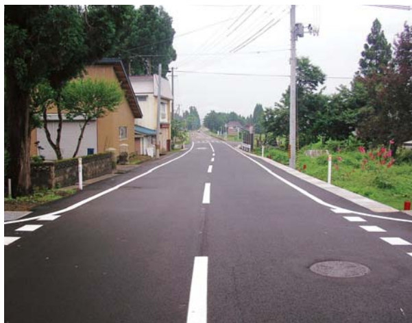
完成写真（全景）
