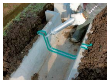
用水路の伸縮目地施工
