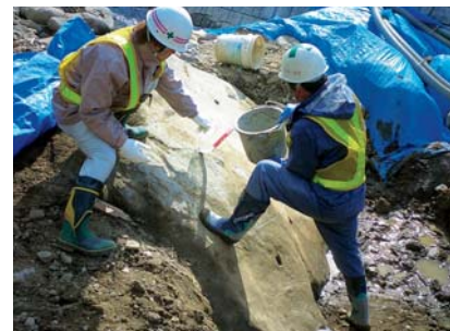
膨張剤注入状況
