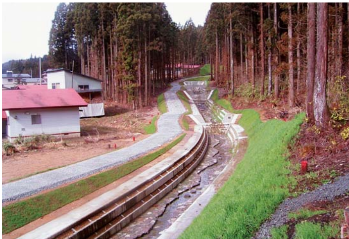
完成写真（全景）
