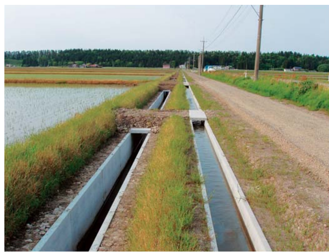
完成写真（用水路、排水路）
