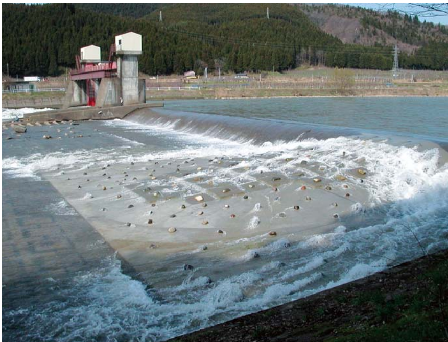
完成写真（全景）
