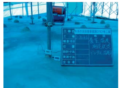
温度管理状況（養生温度）
