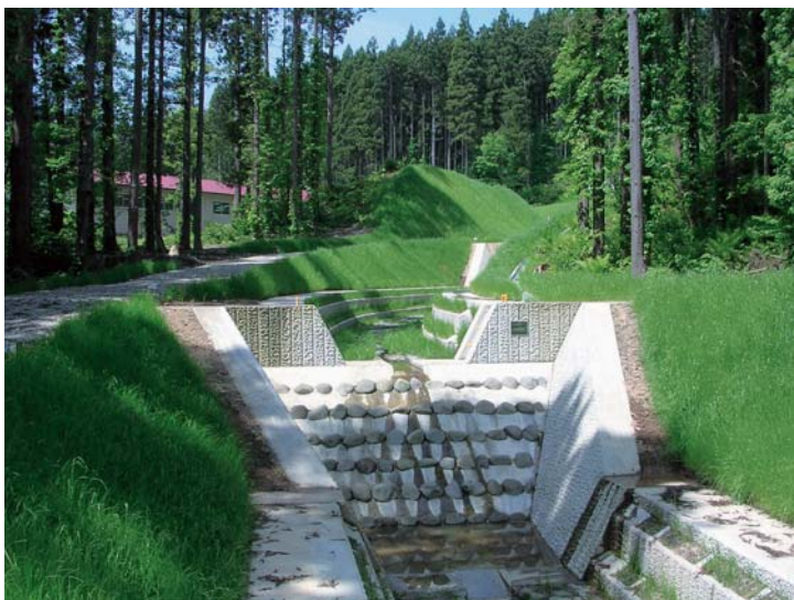
完成後の状況（全景）
