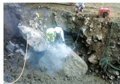
転石の小割作業状況
