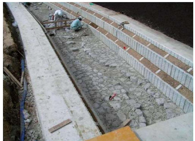
施工定規を使用した石組み施工状況
