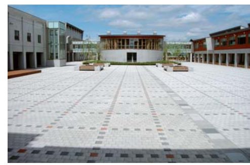
インターロッキング舗装・ベンチ
