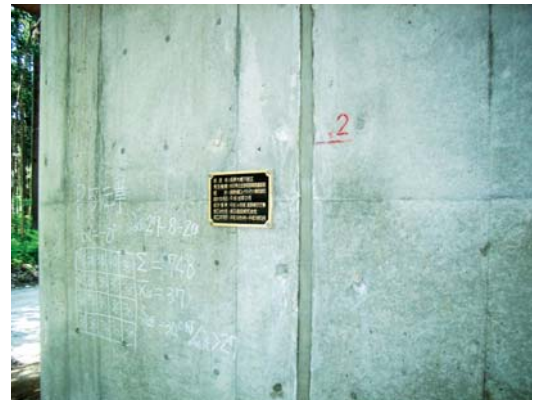
ひび割れ防止対策（誘発目地工）
