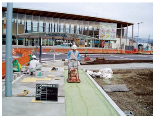
ガラスカレット転圧状況
