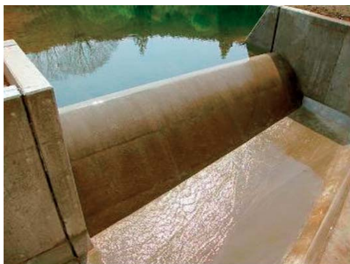
完成写真（側水路：越流部）
