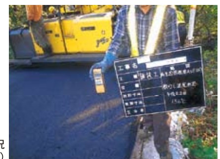
温度管理状況 (敷き均し時)
