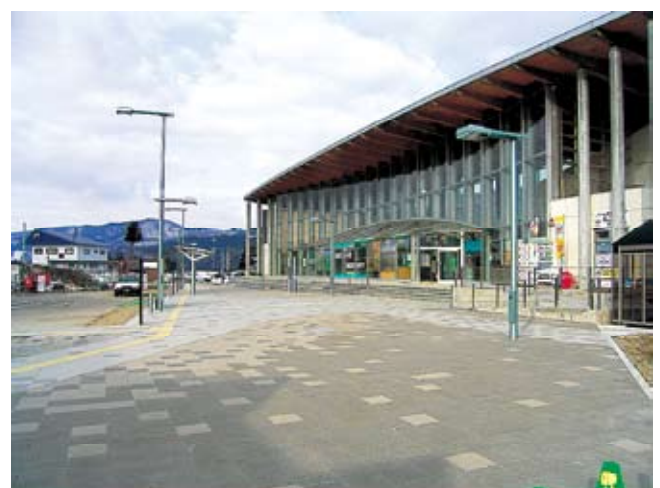
駅前宮ノ前東側 完成写真
