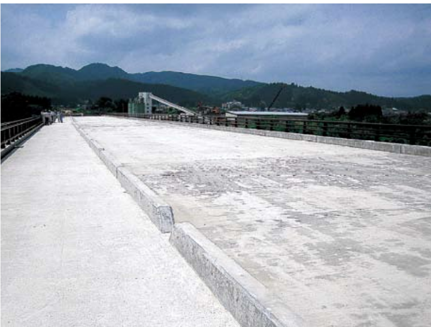
全景(A2橋台側から)
