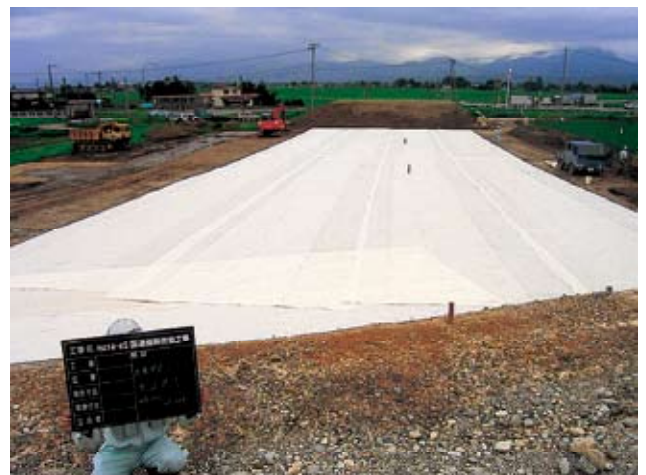
土木シート敷設
