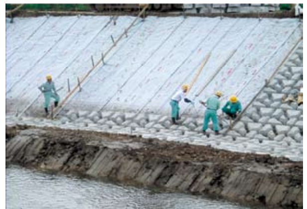
法線高さを調整しながらの慎重な施工
