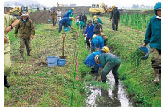
貴重な動植物の移設作業状況
