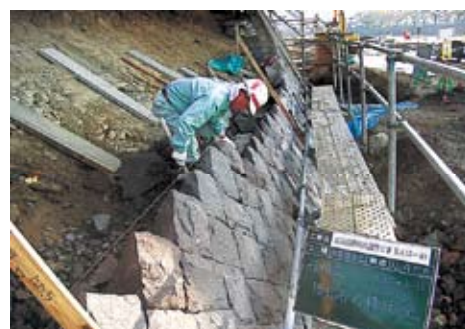
間知石積工の状況
