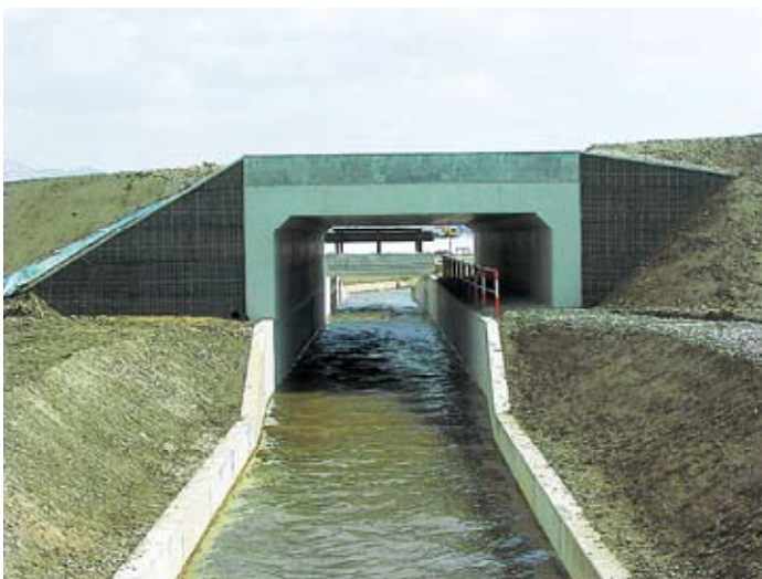
水路函渠工完成写真
