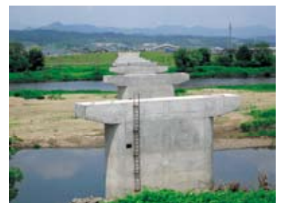
完成写真(全景)
