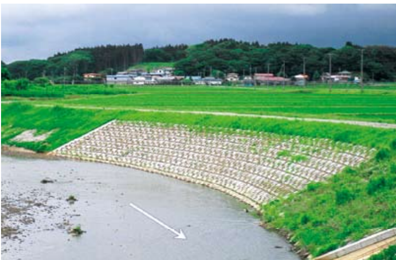
完成写真(見事なカーブ仕上がり)
