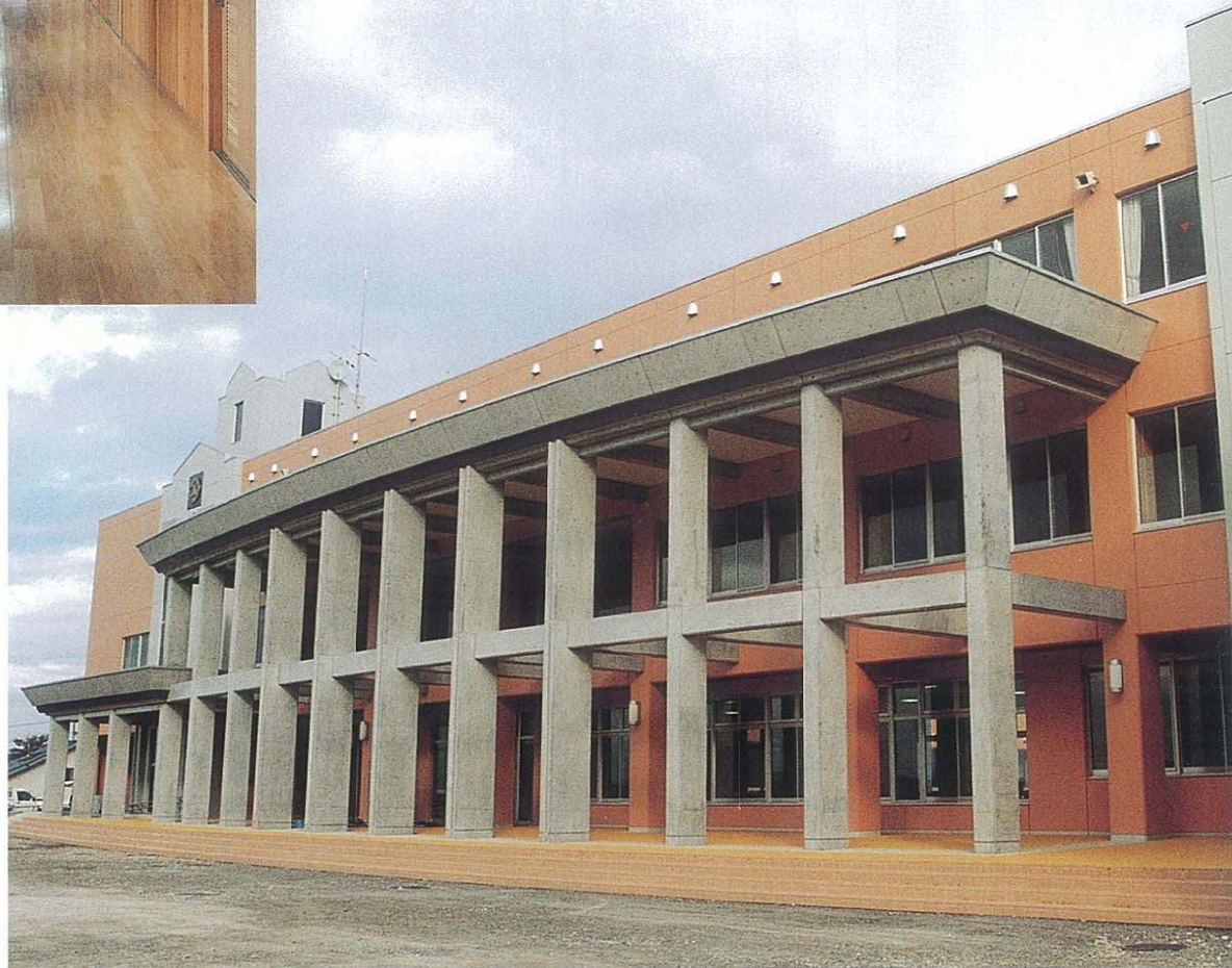
第25回秋田県優良工事表彰から 秋田県立花輪高等学校校舎等改築工事
